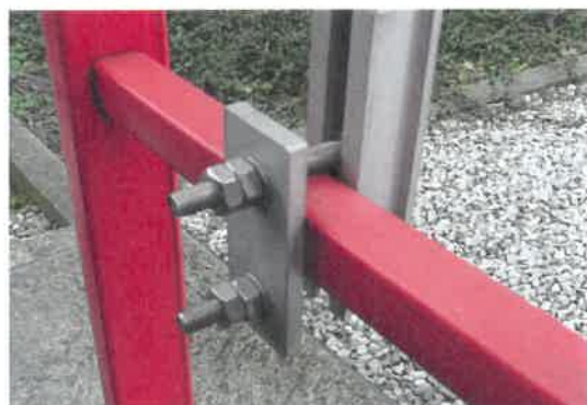
Exemple de fixation au milieu d'un barreau
