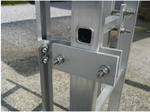
Beispiel für die Befestigung am Leiter-Holm
