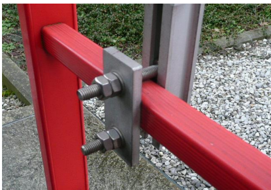
Beispiel für die Befestigung in der Mitte einer Sprosse
